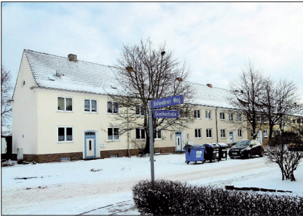
Die modernisierte Siedlung
