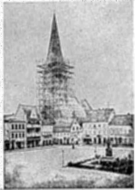
St. Nikolai Kirche zur Zeit der Wiederherstellung
